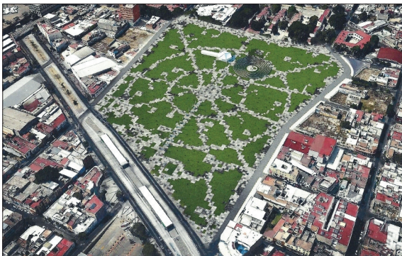
Figura 10. Una de las imágenes objetivo incluidas en el “Proyecto de Reacondicionamiento y renovación de imagen urbana y de paisaje del Parque Morelos” presentado por el Ayuntamiento de Guadalajara. Muestra la inserción del auditorio al aire libre sobre el área de juegos infantiles (fuente: Alcaraz, 2018, p. 370).
